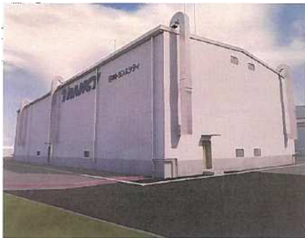
【日本トランスシティ社所有設備】
